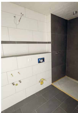
Oben: neue Sanitär-einrichtung in einem Gästezimmer Rechts: 30-jährige Stromfresser (Wäschetrockner)
