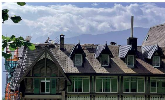
Das Dach des Haupthauses wird mit neuen Eternitplatten versehen
